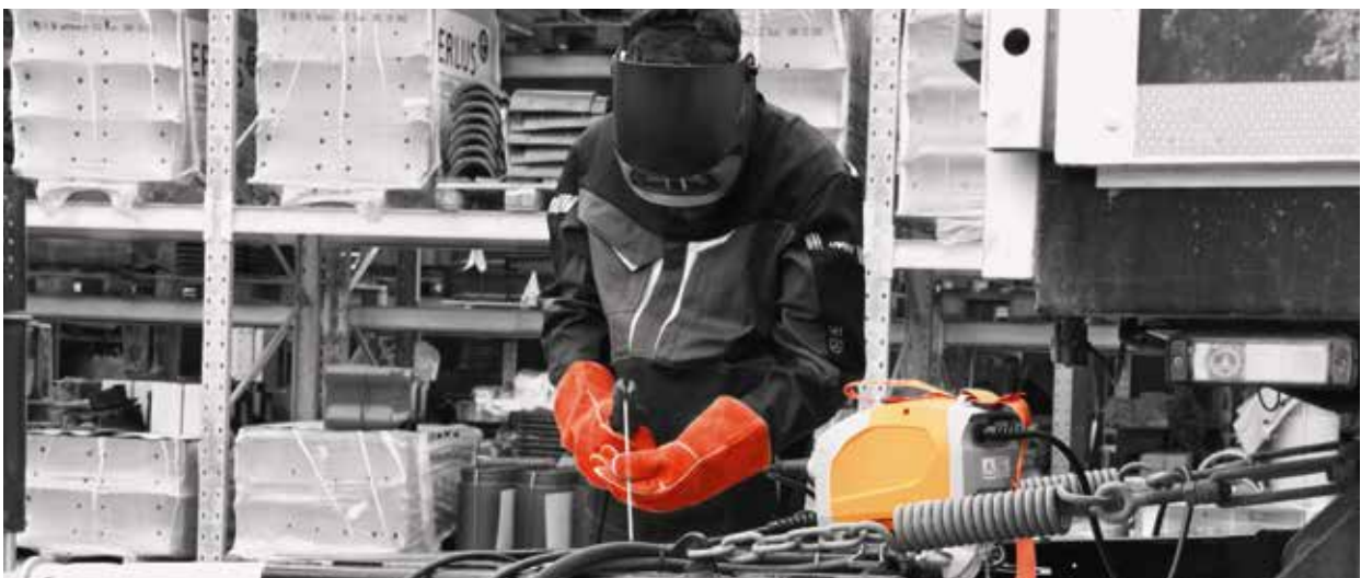
BOOSTER2 beim Reparatur-Einsatz. Immer zuverlässig Einsatzbereit.
